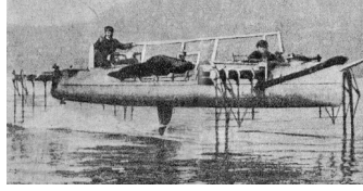
Şekil 2: Forlanini ve merdiven hidrofoilli teknesi
